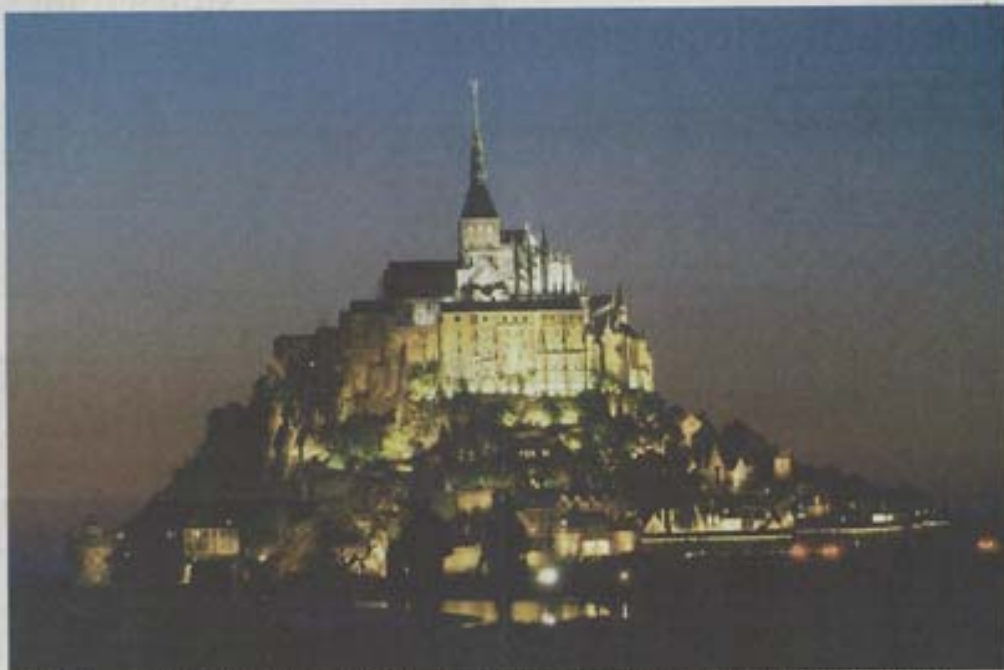
Le site inscrit au patrimoine de l'Unesco est désormais éclairé par près de 1.500 projecteurs pour une puissance électrique d'environ 180 kW. La plupart d'entre eux sont installés autour de l'abbaye, qui domine le rocher.
